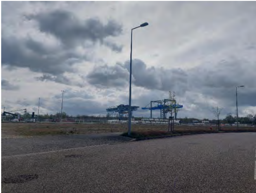
Le nouveau portique à conteneurs (capacité max. : 29 / heure)
